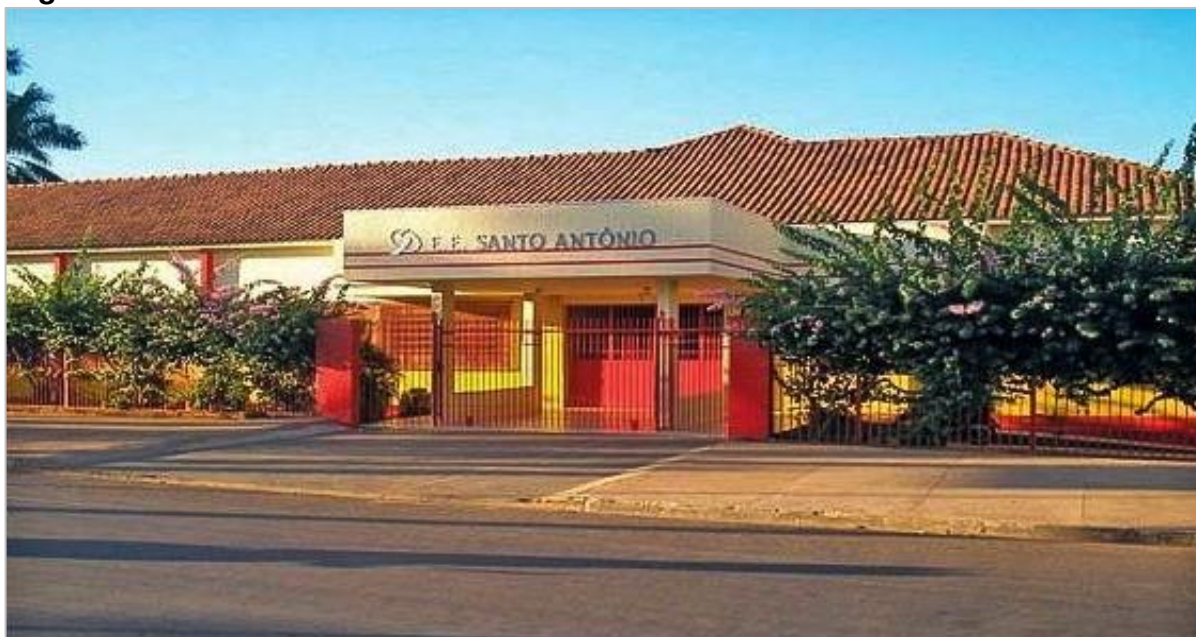
Figura 3 – Fachada da Escola Estadual Santo Antônio
