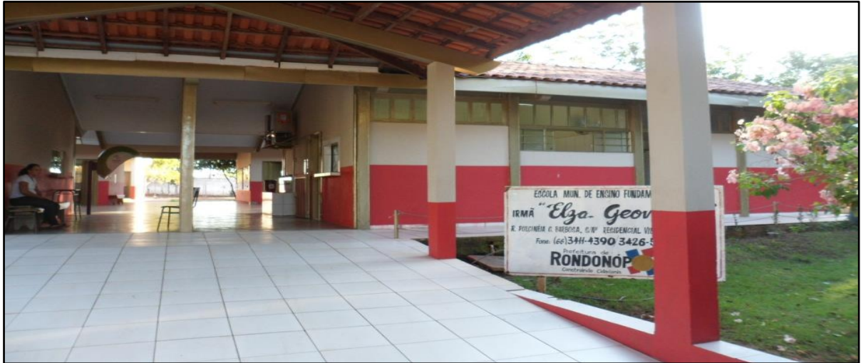
Figura 5 – Rampa de acesso à área coberta da escola
